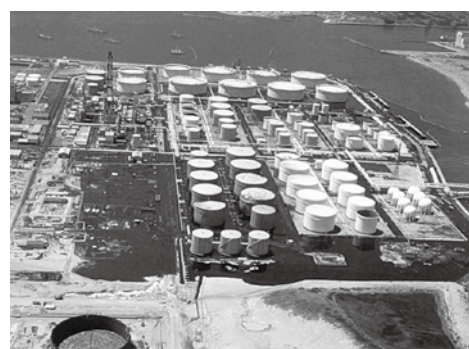
写真2 3基の石油タンクの底板破損による重油流出（1978年宮城県沖地震） 【撮影：河北新報社】
