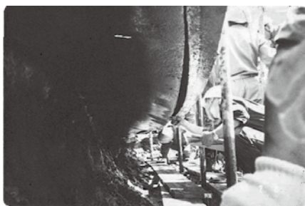
写真1 隅角部（底板）の亀裂（1978年宮城県沖地震） 【撮影：消防研究センター】
